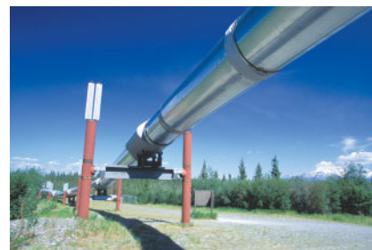
شېۋى 10-9 ھېلا بۇرىا نەفتى ب كاۋۇدى پاراستىيە بهارىكاريا كېلەكى تەربىيى زىنكى.
